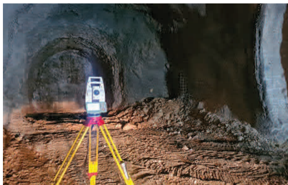
Slika 12. Totalna stanica Leica TS16 – kontrola iskopa proširenja servisne cijevi
