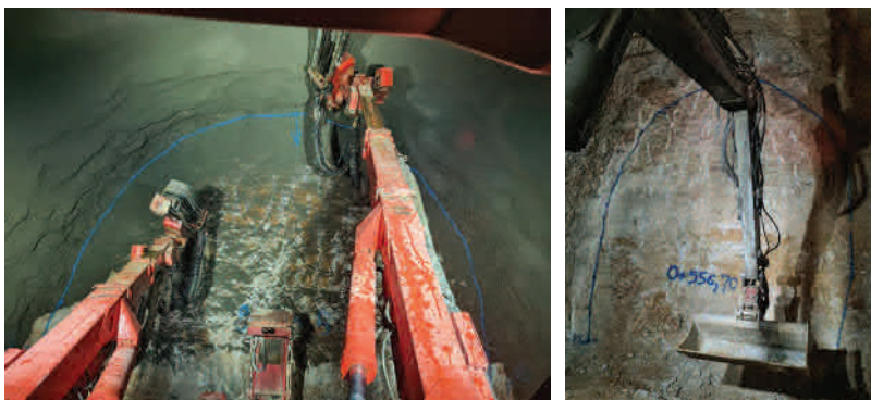
Slika 13. Obilježavanje linije iskopa na obodu stijenske plohe
