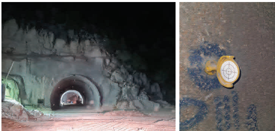
Slika 19. Reflektirajuće prizme ugrađene na mjernim profilima
