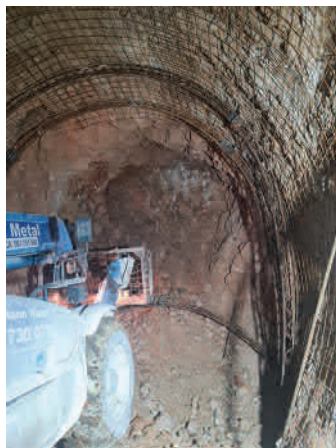
Slika 14.2. Ugradnja remenate
